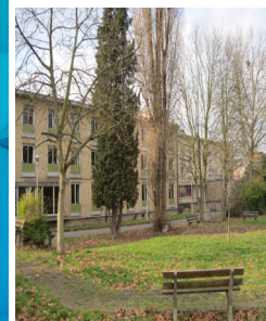
Photos avant travaux Fotos voor de werken
