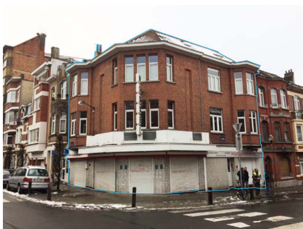
| Immeuble d'angle rue Dansette 10 - Augustines 61
