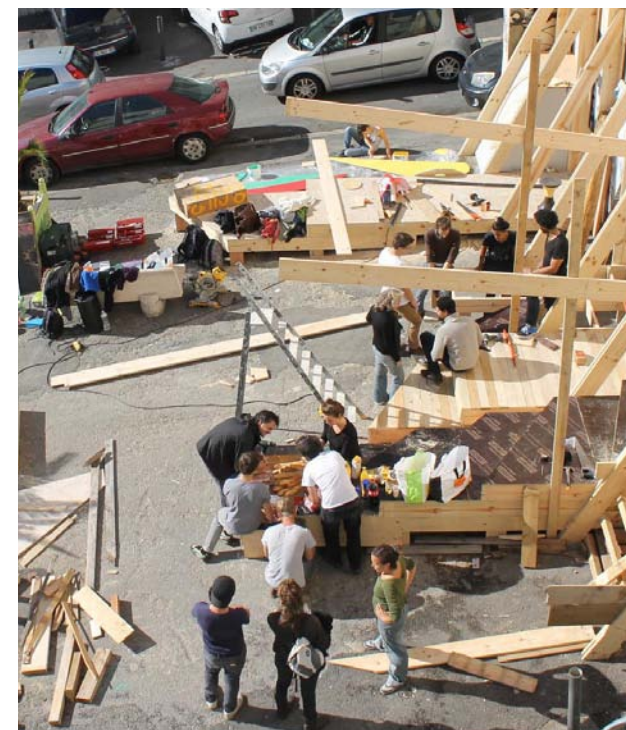
| Chantier participatif - Collectif d'architectes ETC, Marseille source : collectifetc ©
