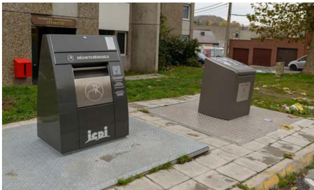
| Gestion des déchets - Conteneurs enterrés, Charleroi source : Quotidien La Meuse ©
