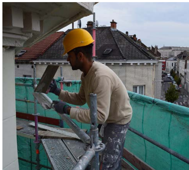
| "Rénovation isolation façade" - Casablanca, Bruxelles source : Casablanca ©
